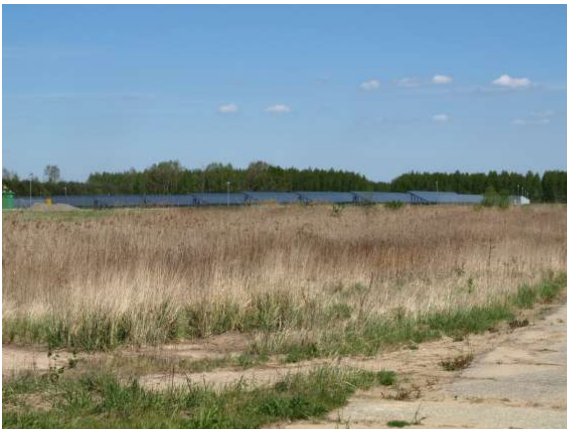
Fot. 20. Istniejąca farma fotowoltaiczna – widok z odległości ok. 220 m
