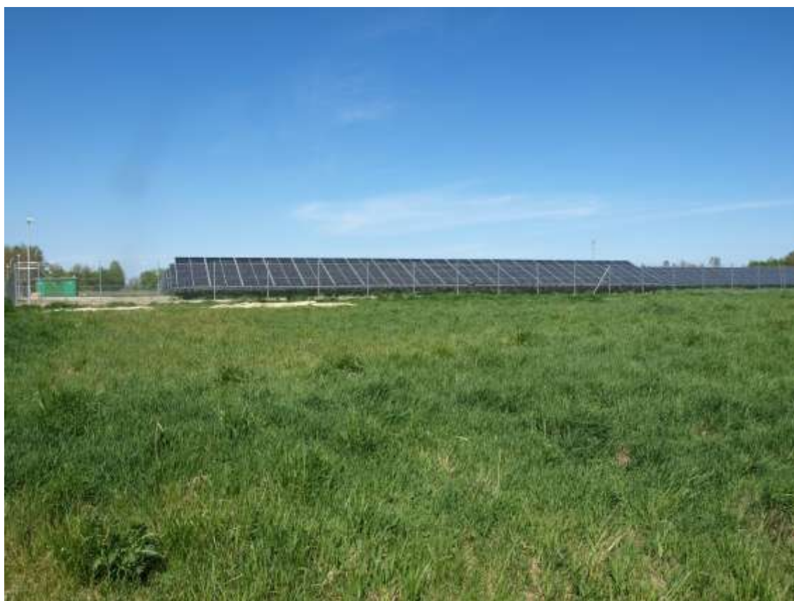
Fot. 19. Istniejąca farma fotowoltaiczna – widok z odległości ok. 50 m
