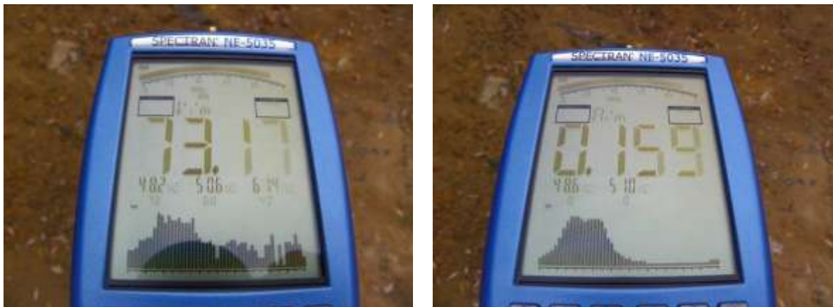
Fot. 23. Pomiar składowej elektrycznej (na lewo) i składowej magnetycznej (na prawo) w punkcie pomiarowym zlokalizowanym w odległości ok. 5 m od transformatora średniego napięcia [fot. Krzysztof Kręciproch]
