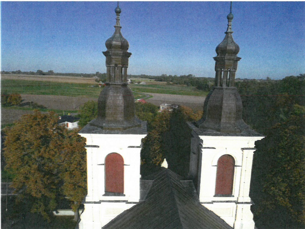
Fot.5 Widok na wieże od strony wschodniej.
