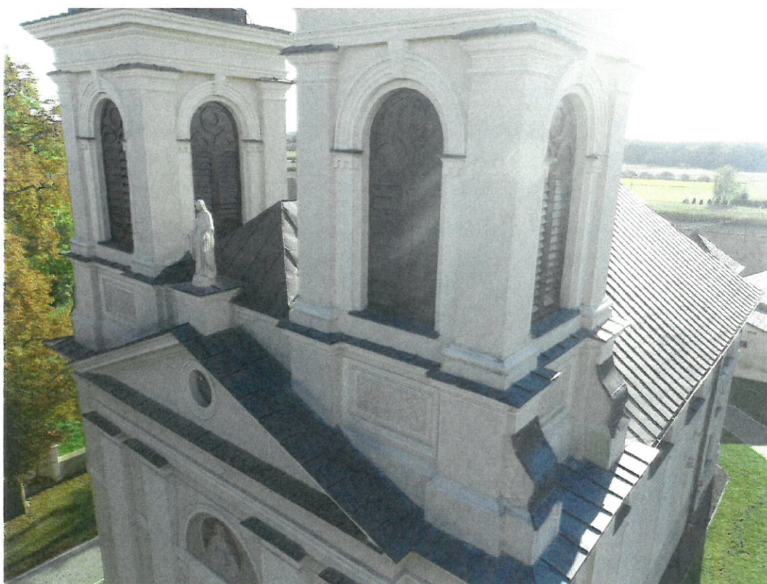
Fot.2 Elewacja zachodnia – widok na żaluzje od strony głównego wejścia do kościoła.
